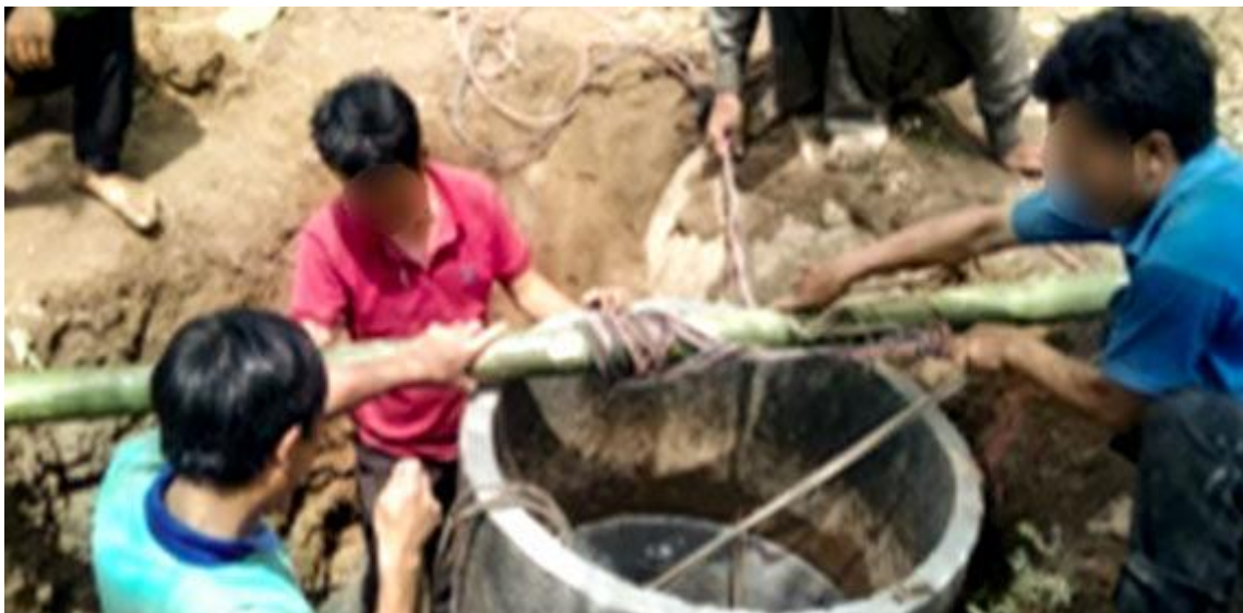
Mit vereinten Kräften entsteht ein neuer Brunnen
